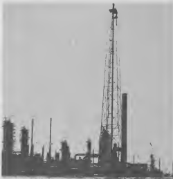
New refinery landmark is the 315-ft. high flare stack. Marca nobo den retineria ta e flare stack di 315 pia.
